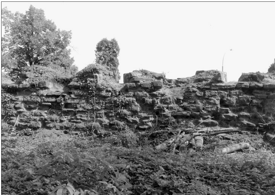
Obr. 25: Český Brod, vnitřní líc hradební kurtiny mezi brankou a jihovýchodní nárožní baštou během průzkumu před opravou. Na koruně se střídají spodní části nik pro stojícího střelce s výše položenými střílnami bez niky (foto Vladislav Razím, 1996).
