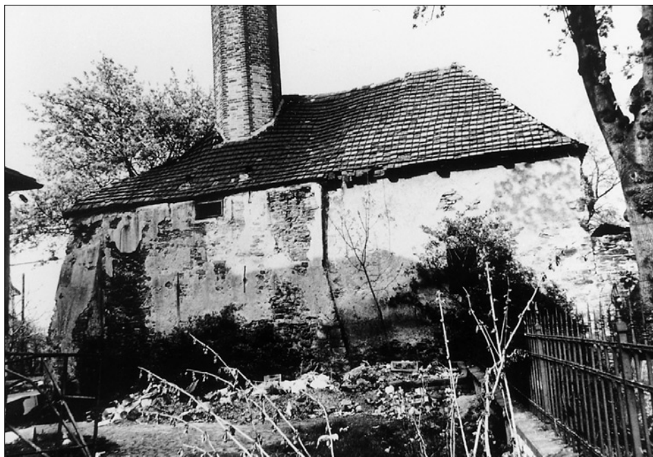
Obr. 13: Snímek západního průčelí zaniklé budovy tvrze v České Brodě podle stavebně historického průzkumu z roku 1971 (cit. v pozn. 102). Vlevo výběh předpokládané hradební zdi z doby arcibiskupa Arnošta z Pardubic (srov. obr. 12), (reprofoto Petr Polák).
