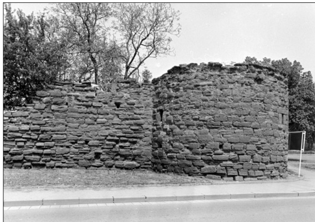
Obr. 24: Český Brod, jihovýchodní nárožní bašta s navazující západní kurtinou. Kromě dvou střílen bašty se dochovala rovněž jedna stojka střílny na koruně hradební zdi (foto Vladislav Razím, 1998).
