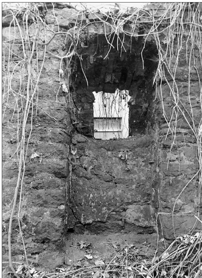
Obr. 18: Český Brod, detail střílny (ústí a záklenek druhotně vyzděny z cihel) s mělkou komorou v severním sousedství hranolové bašty (srov. obr. 16), (foto Vladislav Razím, 1997).
