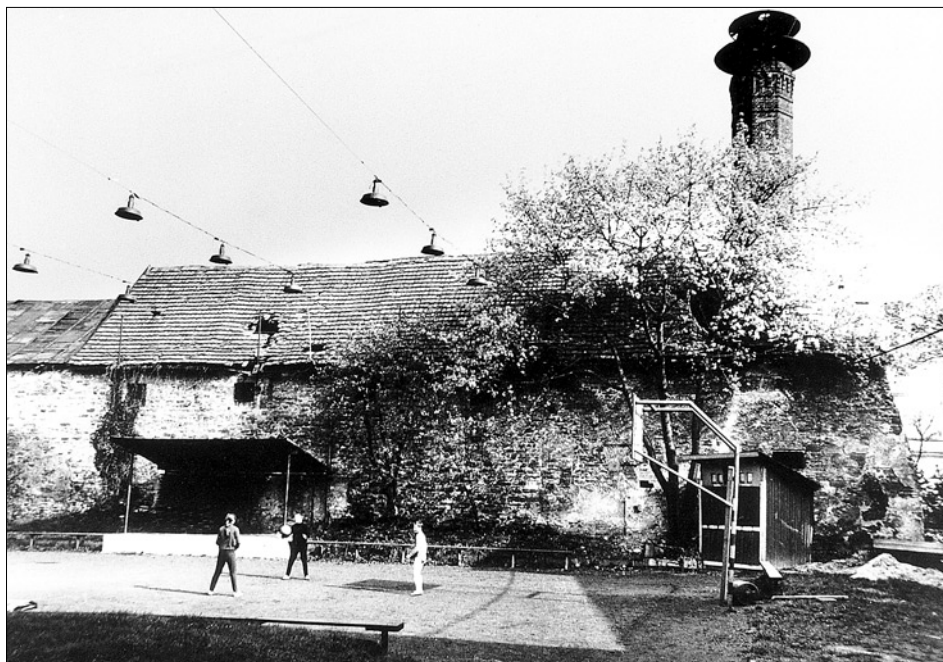
Obr. 12: Snímek severního průčelí zaniklé budovy turze v Českém Brodě podle stavebně historického průzkumu z roku 1971 (cit. v pozn. 102). Struktura zdiva nasvědčuje předpokladu, že šlo o zbytek hradební zdi z doby arcibiskupa Arnošta z Pardubic (reprofoto Petr Polák).
