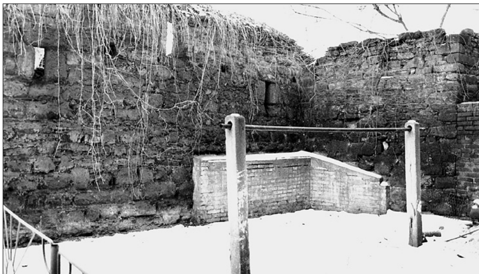
Obr. 15: Český Brod, hranolová bašta severně od zaniklé Pražské brány (vpravo) s částí navazující kurtiny. Ve vnějším lici kurtiny tři střelny (foto Vladislav Razím, 1998).
