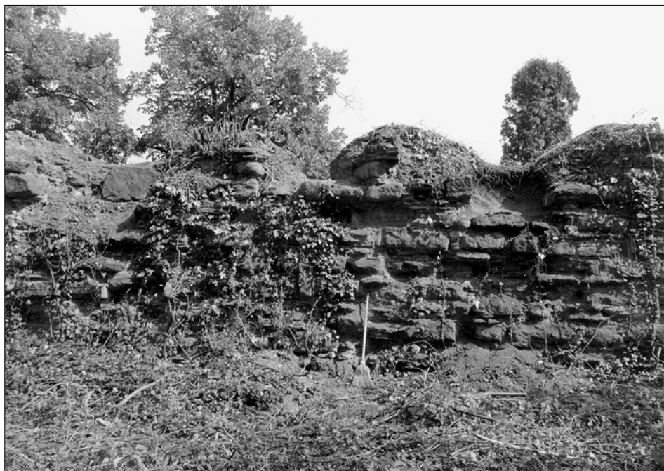
Obr. 26: Český Brod, vnitřní líc hradební kurtiny mezi brankou a jihovýchodní nárožní baštou během průzkumu před opravou (srov. obr. 25). Čelní stěna některých nik pro stojícího střelce byla tvořena postaveným plochým kamenem (vlevo), (foto Vladislav Razím, 1996).
