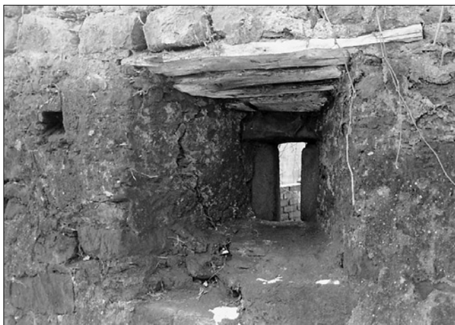
Obr. 17: Český Brod, detail střílny v severním sousedství hranolové bašty (srov. obr. 16, střílna vlevo). Dole při ostění dochována dřevěná přičle pro zaklesnutí hákovnice (foto Vladislav Razím, 1998).
